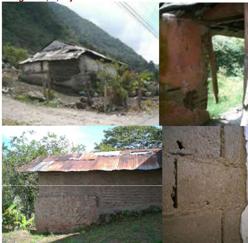
Figura 6, 7, 8 y 9. Viviendas Rurales en el estado Mérida
